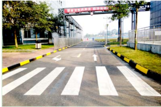
安全可视化建设 - 道路标线
