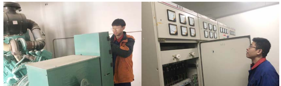
电工班组每1小时对全厂各个车间、配电室及发电机的电流、电压进行巡检。
